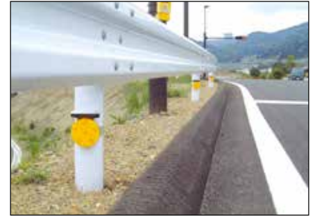
B・C種ガードレール支柱取付け (Φ114.3取付けバンド)
