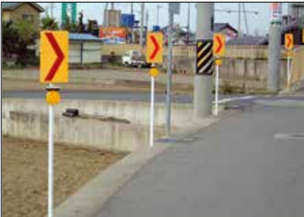
線形誘導標支柱取付け (Φ34取付けバンド)
