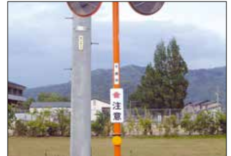
カーブミラー支柱取付け (Φ76.3取付けバンド)
