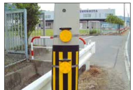
電柱取付け (SUSバンド)
