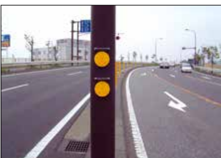
信号機柱取付け (SUSバンド)
