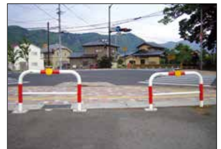
車止め(横パイプ)取付け (Φ60.5取付けバンド)
