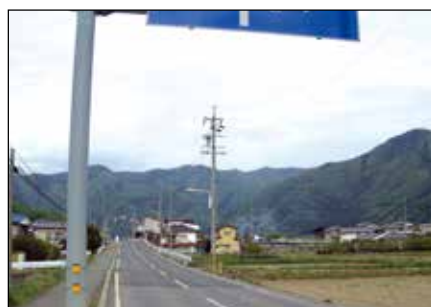
大型標識柱取付け (SUSバンド)
