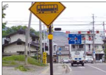
警戒標識支柱取付け (Φ60.5取付けバンド)
