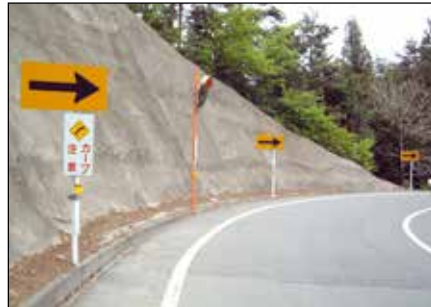
矢印板支柱取付け (Φ76.3取付けバンド) カーブミラー (Φ89.1 SUS-1バンド)
