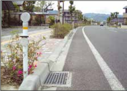
Φ100デリネーター支柱取付け (Φ60.5取付けバンド)
