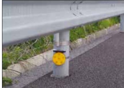
A種ガードレール支柱取付け (SUS-1バンド)
