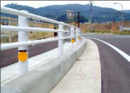
B・C種ガードパイプ支柱取付け (Φ114.3取付けバンド)
