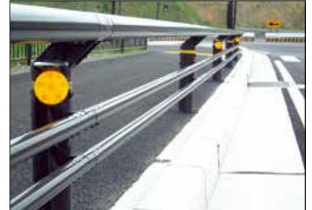
A種ガードパイプ支柱取付け (SUS-1バンド)
